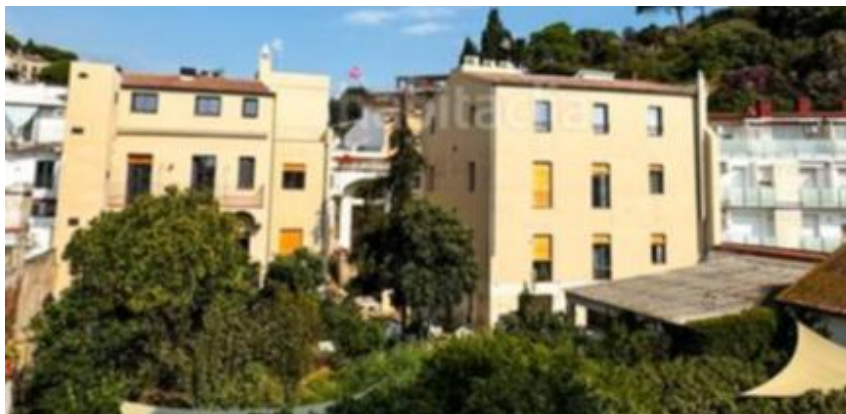
Caldes d'Estrac - Caldetes. Jardins i vista posterior dels edificis i la Portalada de Can Vidal (antiga Fonda Vidal)
