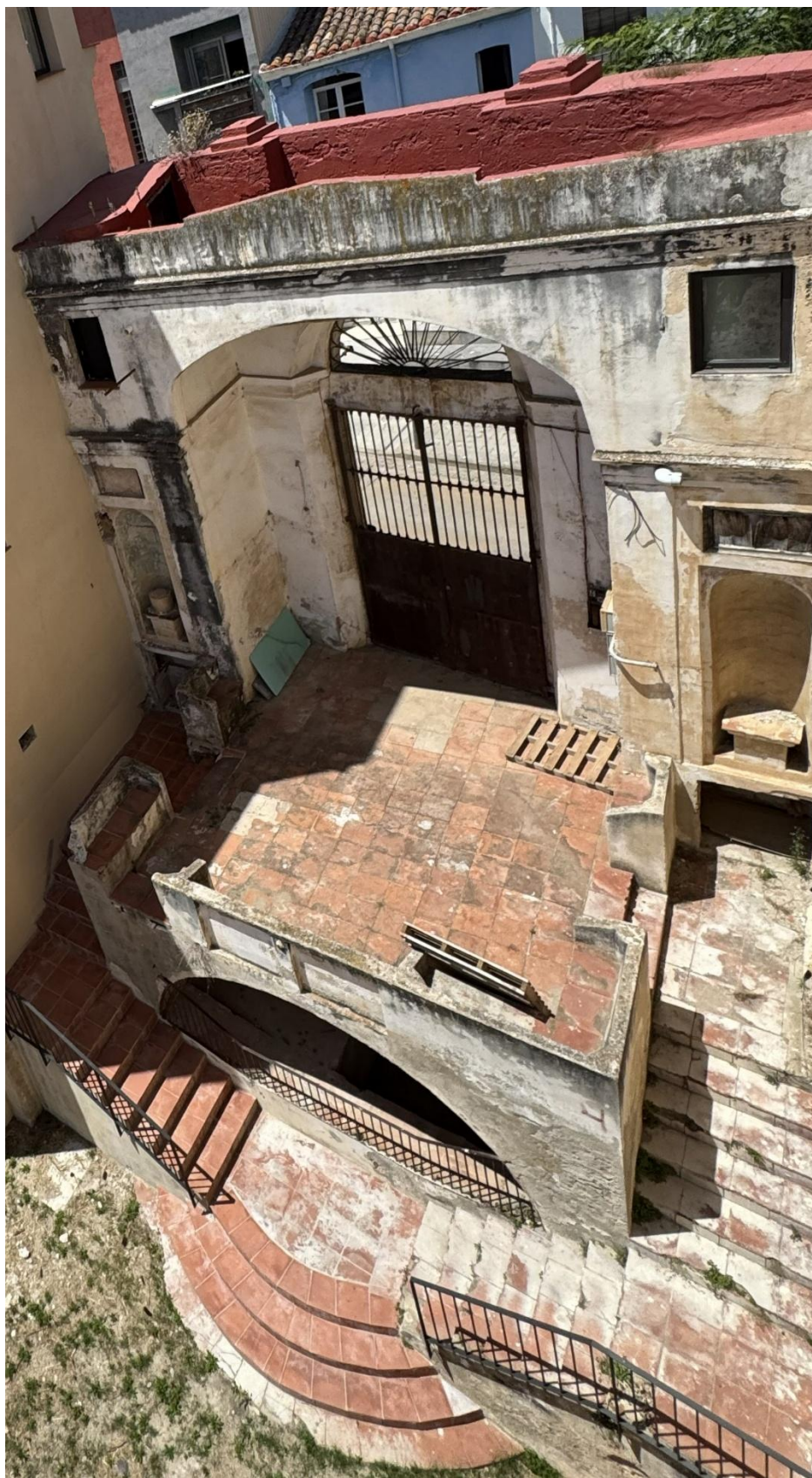
Caldes d'Estrac – Caldetes. Estat actual de la façana interior de la portalada de Can Vidal, reformada el 1872 sota la direcció de Manuel Guitart i Codorniu (atrib.)
