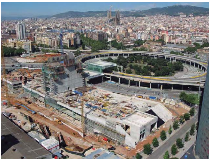
Obres de construcció de la seu del nou Museu del Disseny de Barcelona a la Plaça de les Glòries, 2015
