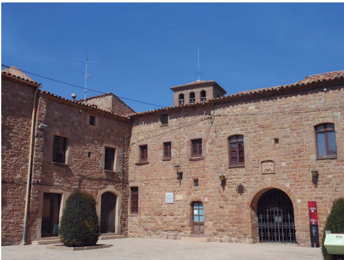
Façana exterior del recinte de la clausura del monestir de Santa Maria de l'Estany (Moianès, Barcelona), amb edificacions d'èpoques diverses.
